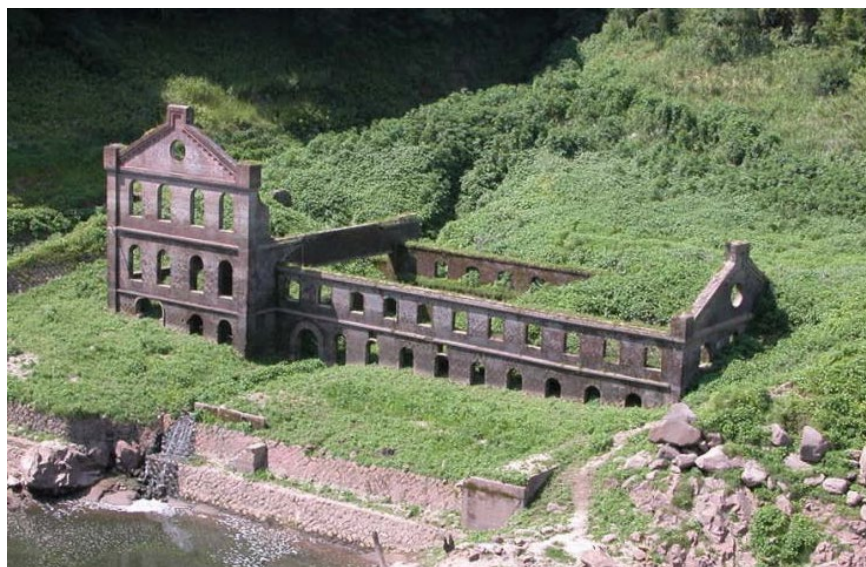
崩壊前の曾木発電所遺構
