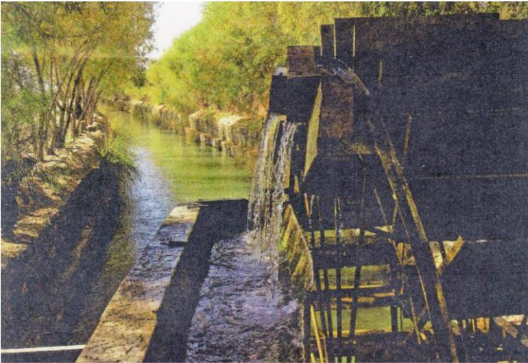
カンレイ村の水車。福岡県朝倉市の水車を参考に作られた。毎日1200トンの水を汲み上げている。ちなみに、「マルワリード用水路」は全長24.837km、灌漑面積3000ha。
