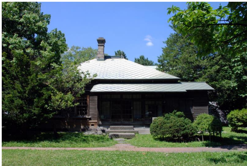
旧永山武四郎邸。木造の邸宅部分（写真上）、洋館の木造クラブ部分（写真下）
